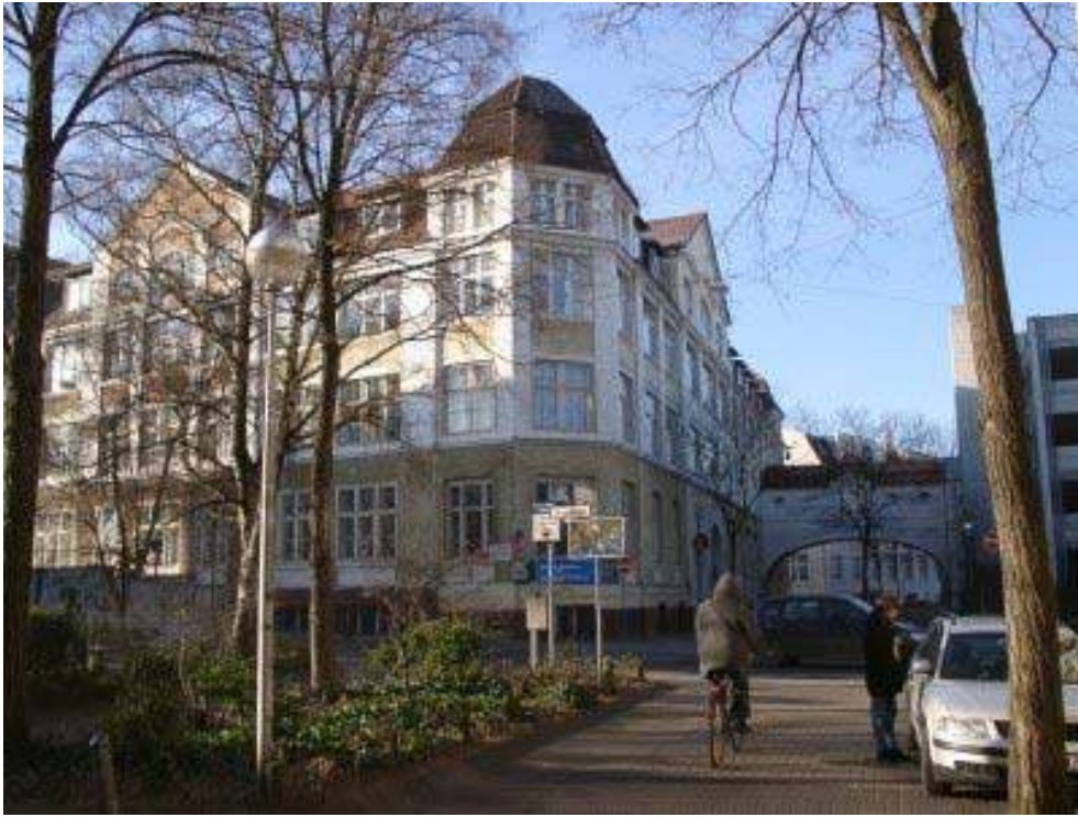
Dienstgebäude in der Ravensberger Straße 12
