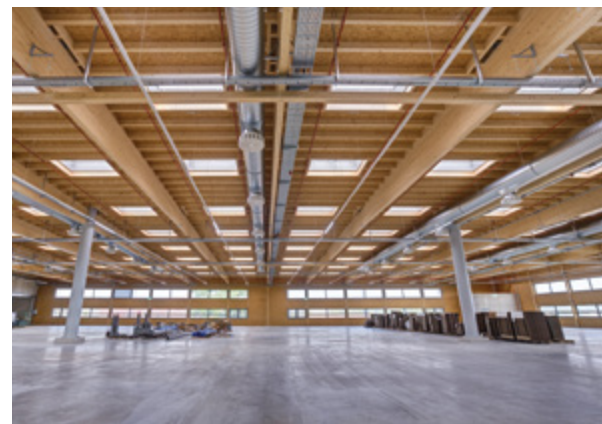
Die Produktionsebenen sind beinahe stützenfrei.
