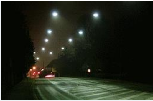
Alte Seil-Kofferleuchte, Systemleistung 137 W (links); Neue LED-Leuchte, Systemleistung 41 W
