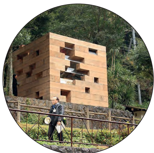
Abb. 27: „Final Wooden House“, Sou Fujimoto
