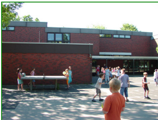
Abbildung 3: Neue Grundschule Babenhausen
