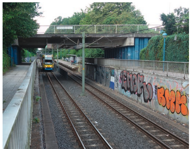
Abbildung 12 Stadtbahnstrecke im Bereich Schelpmilser Weg
