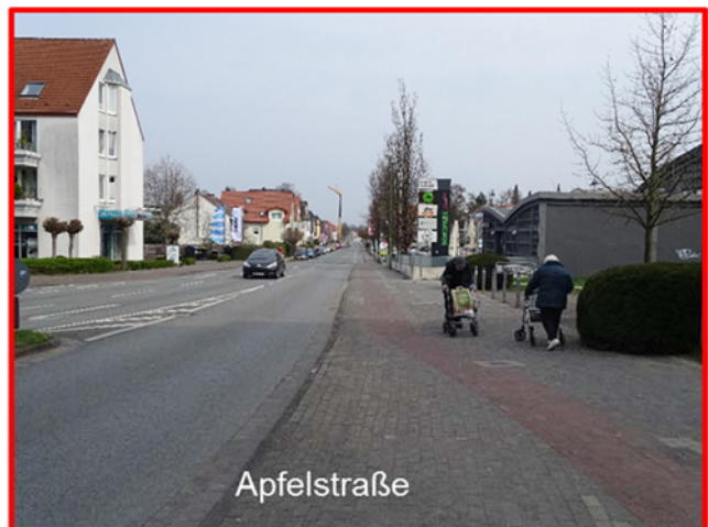
Abb. 26: Trennung zwischen Geh- und Radwegen muss mindestens 30 cm breit sein; gelungene Ausführung (grüne Umrandung) und fehlende Trennung (rote Umrandung)
