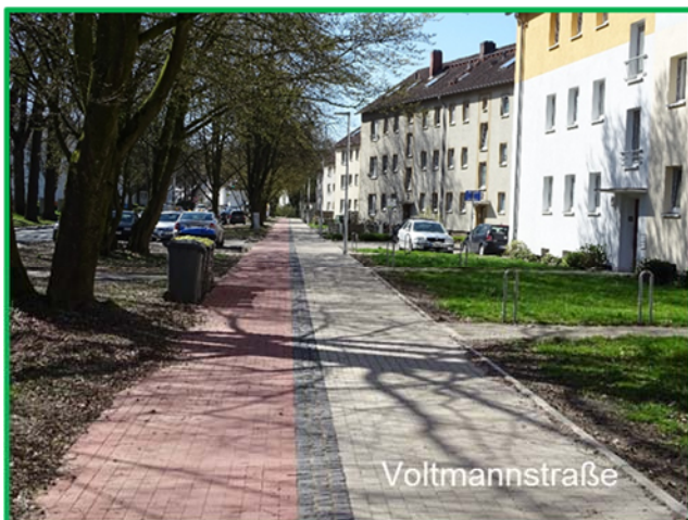
Abb. 26: Trennung zwischen Geh- und Radwegen muss mindestens 30 cm breit sein; gelungene Ausführung (grüne Umrandung) und fehlende Trennung (rote Umrandung)
