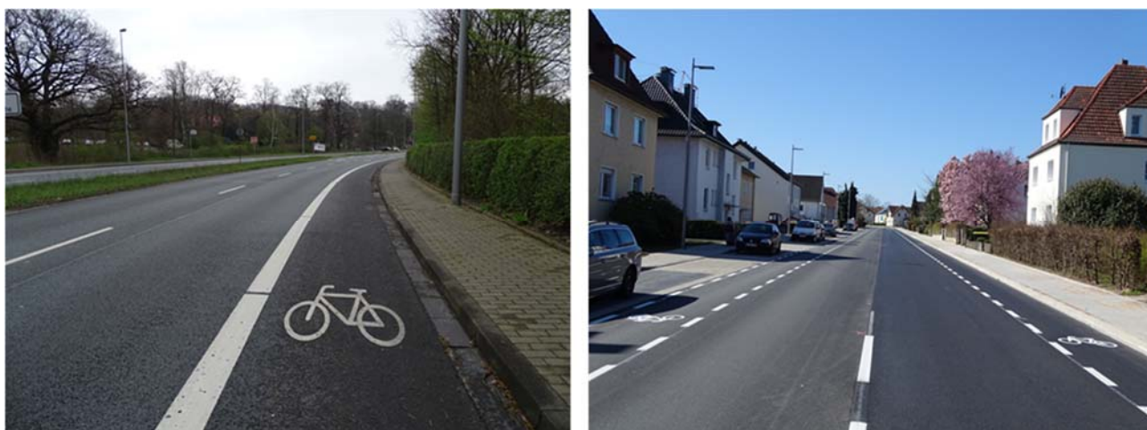
Abb. 25: Beispiele vorgefundener Führungsformen: Radfahrstreifen auf dem Südring (links); Schutzstreifen entlang der Voltmannstraße (rechts)
