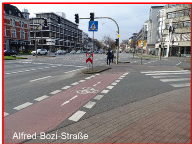
Abb. 27: Konfliktpunkte aufgrund eines Zwei-Richtungsradweges
