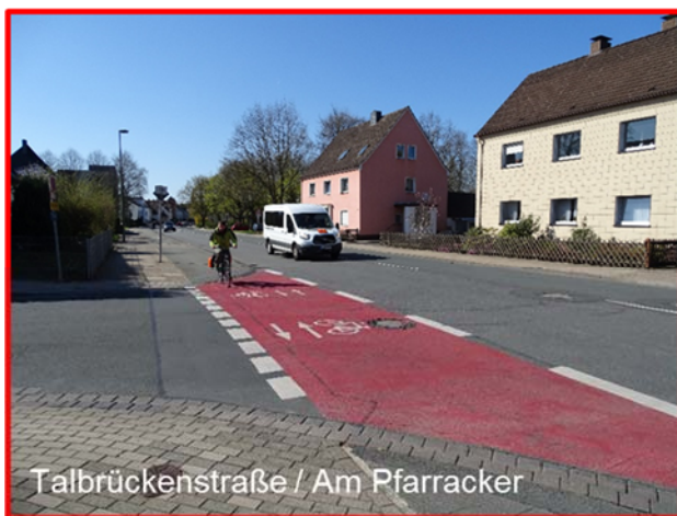
Abb. 27: Konfliktpunkte aufgrund eines Zwei-Richtungsradweges
