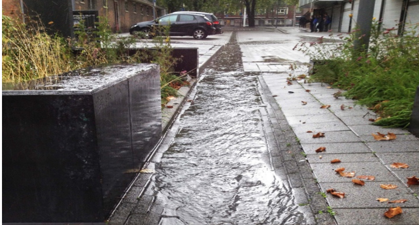
Notableitung von Niederschlagswasser im Straßenraum
