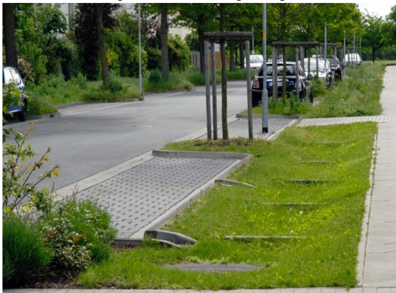
Wasserrückhaltung und -versickerung in begrünten Mulden
