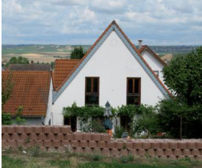
Mauer aus Wall-Steinen entlang des Grundstückes
