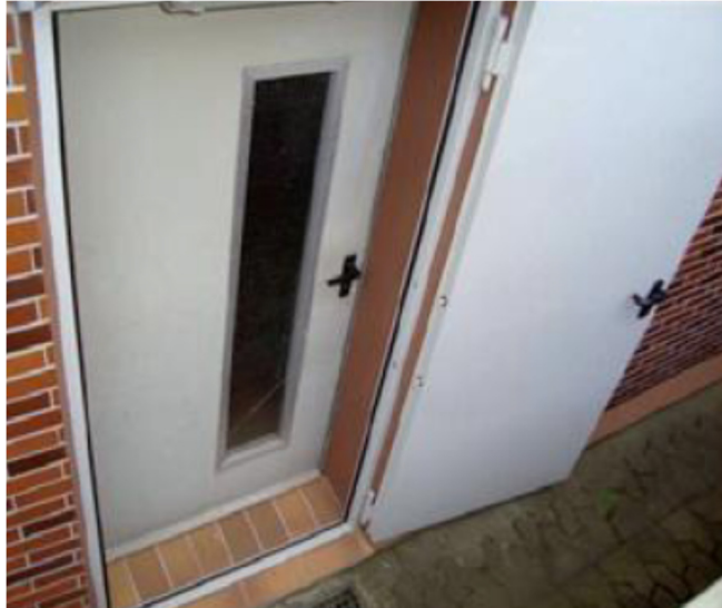
Nachträglicher Einbau einer Schutztüre an Hauszugängen
