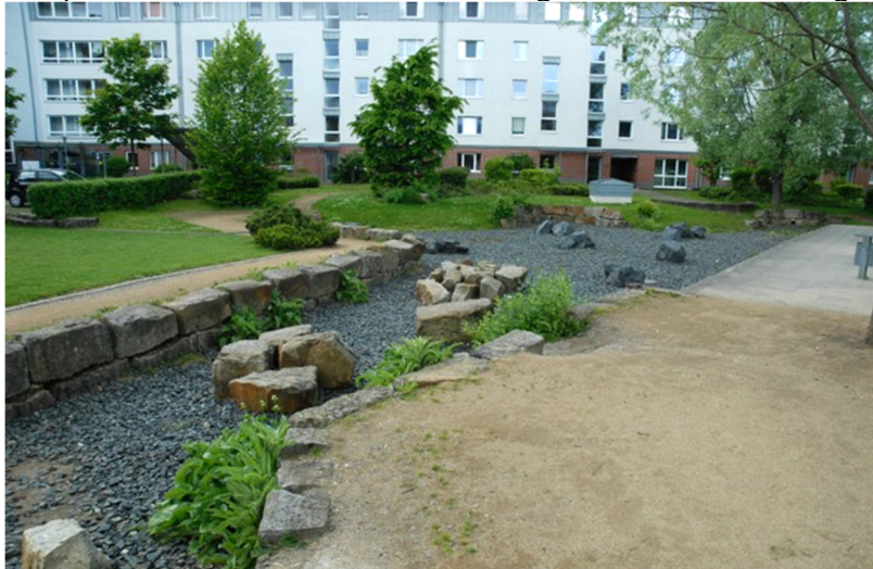
Temporärer Rückhalt von Niederschlagswasser bei Starkregen
