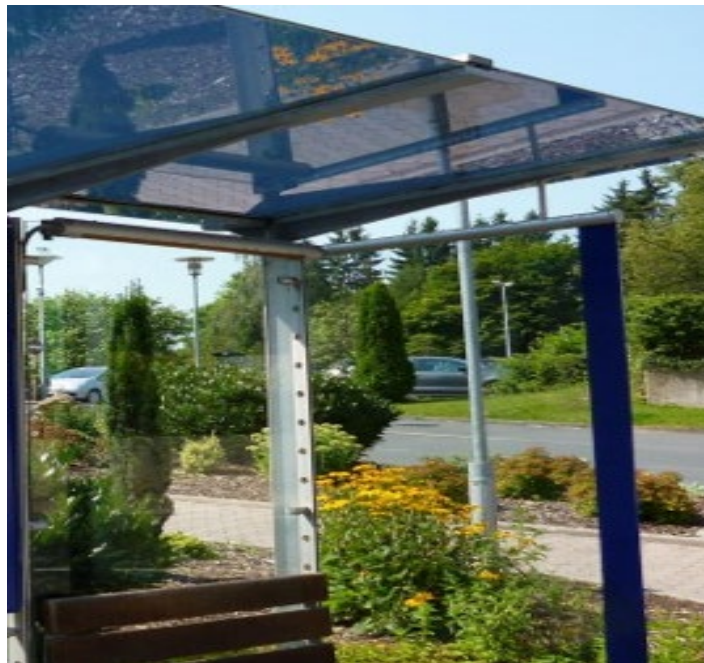
Schattenspende durch eine Glasdachkonstruktion
