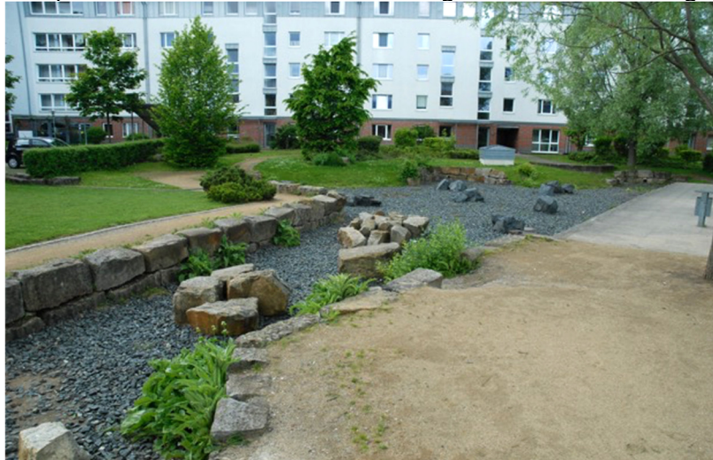
Temporärer Rückhalt von Niederschlagswasser bei Starkregen
