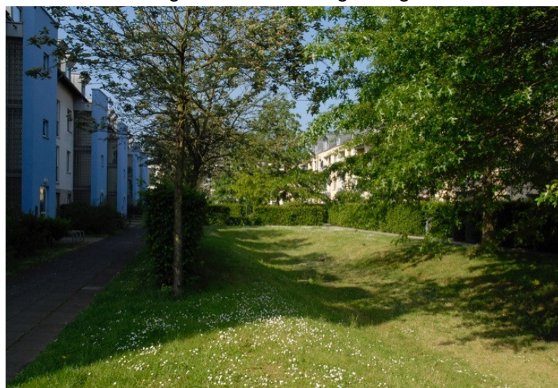
Wasserrückhaltung und -versickerung in begrünten Mulden
