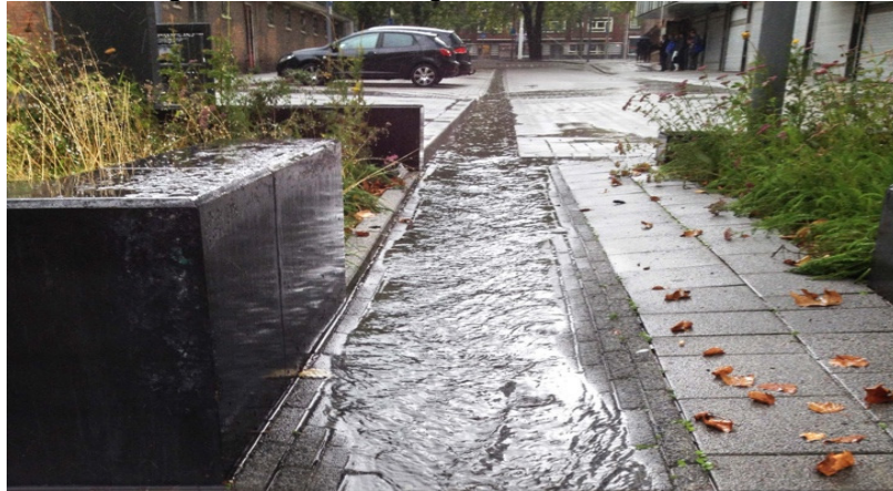
Notableitung von Niederschlagswasser im Straßenraum
