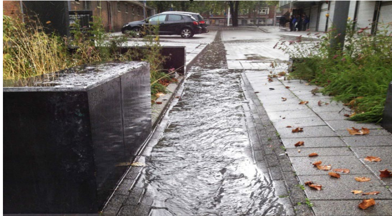
Notableitung von Niederschlagswasser im Straßenraum
