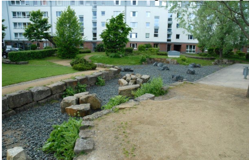
Temporärer Rückhalt von Niederschlagswasser bei Starkregen
