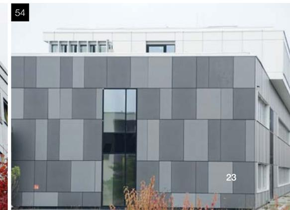
Ein weiterer Vorteil dieser Fassadenkonstruktion ist, dass das regelmäßige Streichen der Fassade entfällt. Langfristig gesehen spart man also einen Teil der Kosten für die teurere Neuanschaffung wieder ein.
