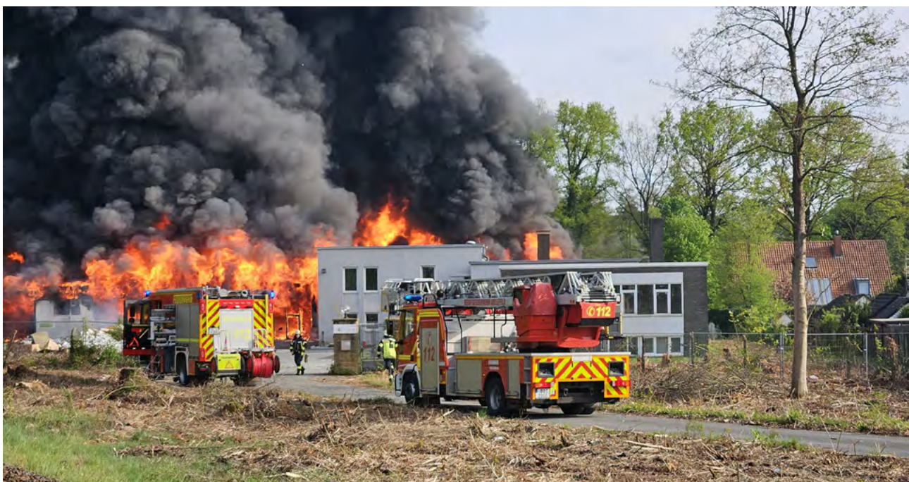
Bild 3: Brandeinsatz an der leerstehenden Boulderhalle in Senne.
