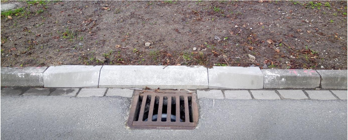
Flachbordstein F10 an der Brinkstraße
