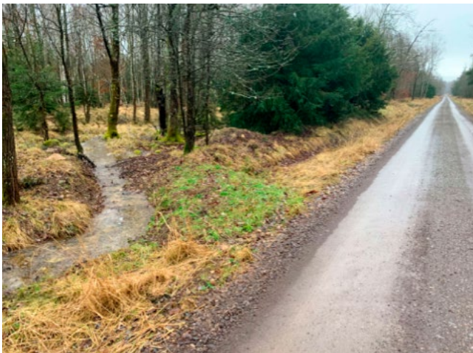
Abb. 11.2: Abschlag zur Einleitung von Regenwasser in den Bestand und Einbau einer Rigole aus grobschlägigem Buntsandstein beim Wegeneubau (aus Frauenberger 2024)
